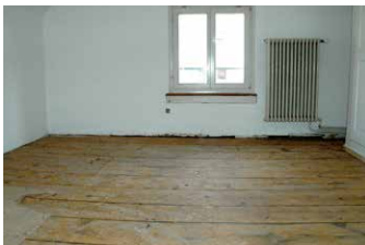
Tannenbretter (1895), EFH Winterthur: Nivelliermasse entfernt, geschliffen, versiegelt. 6 Zimmer, 3 Korridore (110 m 2 ).
